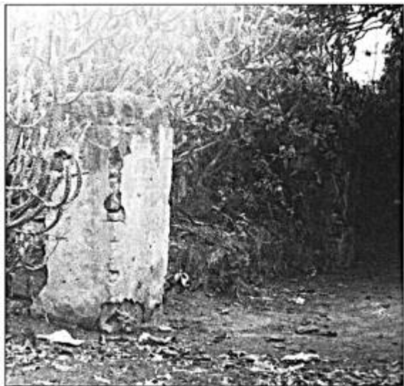
Ilustración 67: Vista de la esquina sureste de las ruinas de la ermita de San Andrés, la pared trasera llena de cactus, reforzada con contrafuertes de baja altura y zapata corrida. Seguramente para soportar los empujes laterales de la pequeña cúpula de media naranja y bóvedas de baúl cubriendo el presbiterio y las capillas laterales respectivamente. (Fot. del Autor, 1970).
