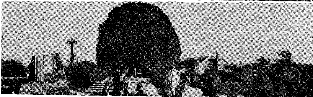
El Parque Darío también sufrió en sus muros la violencia del sismo.
