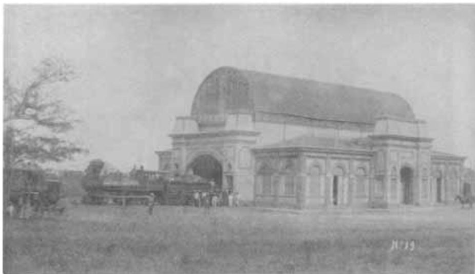
No. 19. Estación de Granada al salir el tren.
