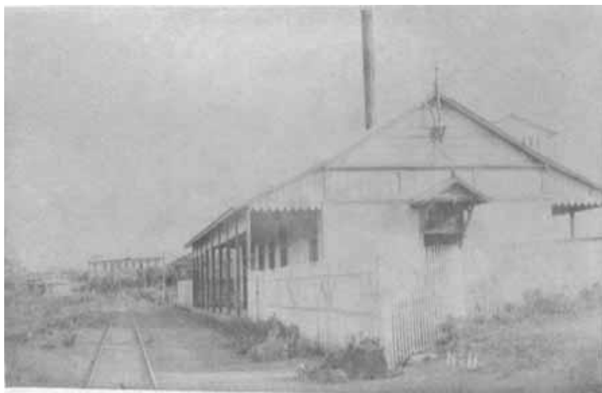
No. 11. Casa de la máquina de hielo en Managua.
