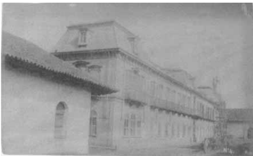
No. 4. Palacio principal de Managua.
