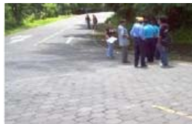
Foto N° 2 Vía Quebrada Honda – Valle La Laguna. INETER 2011.
