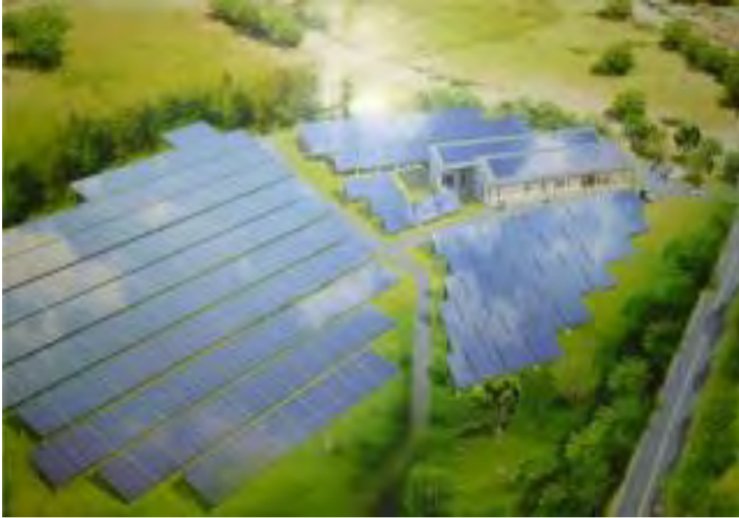
Vista aérea de la planta de energía solar de La Trinidad
