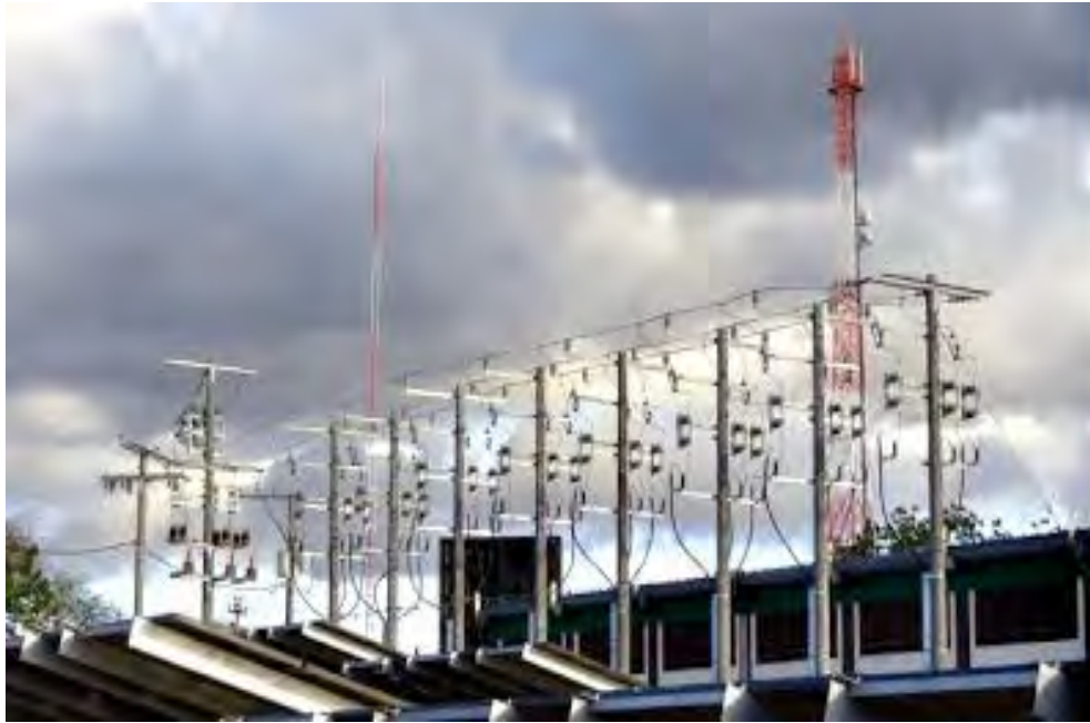
La planta está interconectada a la red eléctrica nacional ■
