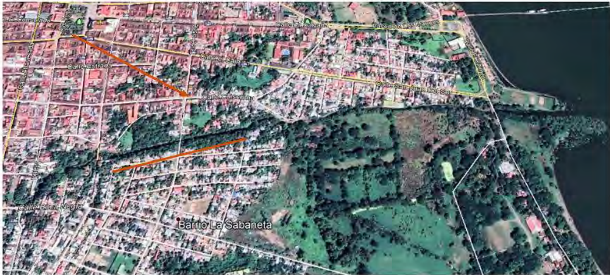
Arroyo Zacatiligüe cerca de su desembocadura. La sección recta es el movimiento de tierra hecho en 1888 de tres mil varas cúbicas para desviar las aguas que antes se vertían sobre la calle Cuiscoma. Nótese la acumulación de sedimento en la descarga en el Lago. La flecha roja señala la calle de Cuiscoma, y la línea recta es paralela a la excavación de 1888.
