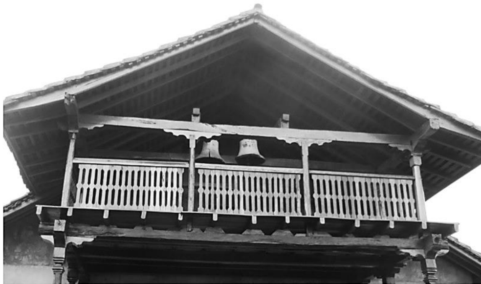
El balcón todo elaborado en madera, con su baranda compuesta de balaustrada de tablillas con diseño geométrico.
