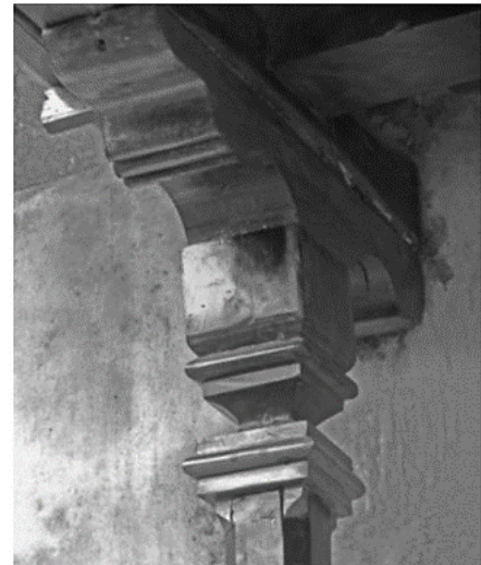
Zapata que sostiene el balcón
