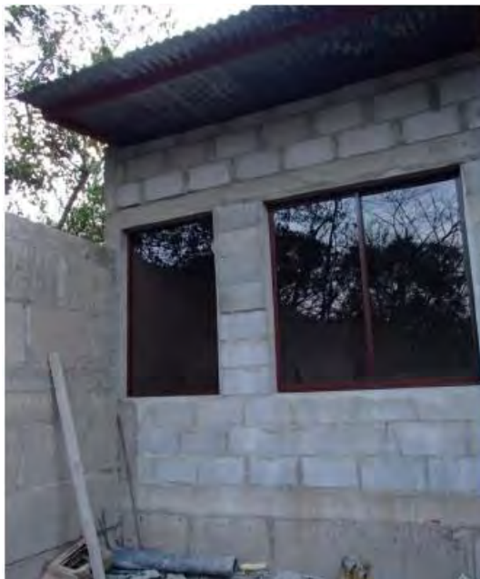
Figura 8: La pared exterior del edificio de concreto estudiado en Matagalpa, Nicaragua. Foto del autor
