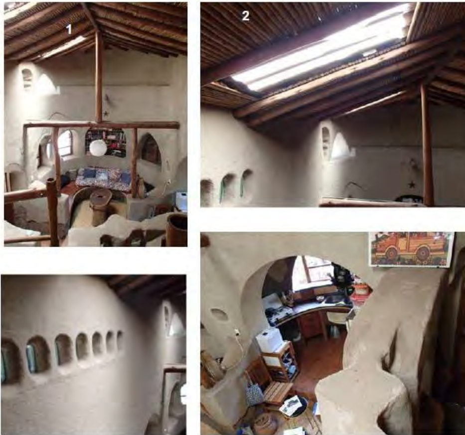
Figura 4 Arriba desde la izquierda: 1. La sala de estar con el sofá bahareque, 2. El techo con la claraboya. Abajo de izquierda a derecha: 3. La pared de bahareques con las botellas de vino y 4. La cocina. Fotos del autor
