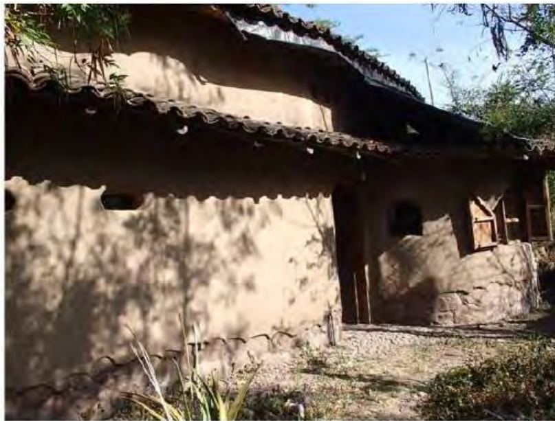
Figura 6: El exterior de la casa de bahareques. Foto del autor
