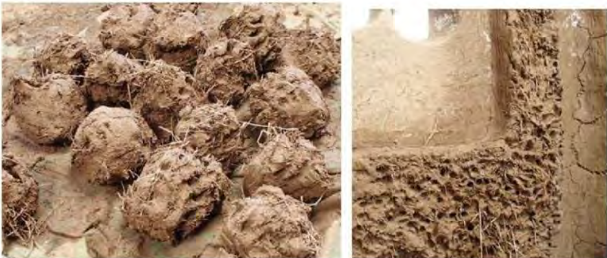
Figura 2: Terrones de bahareque y una pared de bahareque en fase de construcción. Foto del autor
