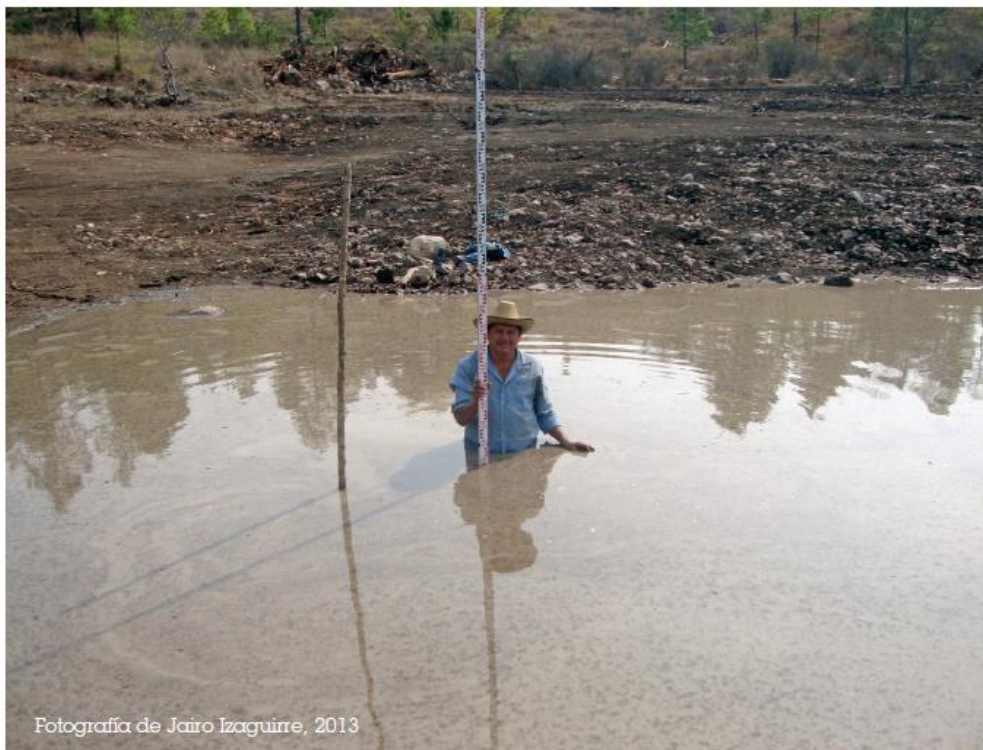
Fig. 5. Inicio de obra de captación de agua, Icalupe, Somoto, Nicaragua.
