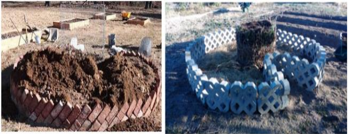
Acumulación de tierra para el huerto y huerto con canasta central finalizada, aun sin acumulación de tierra.
