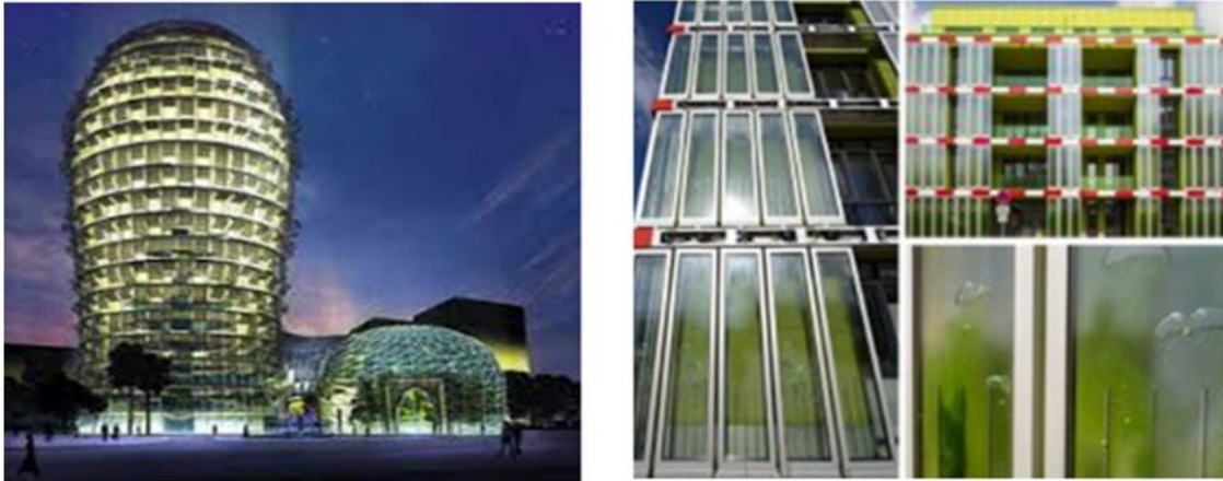
Edificio Qatar Sprout (Doha) y Edificio Bic House (Hamburgo)
